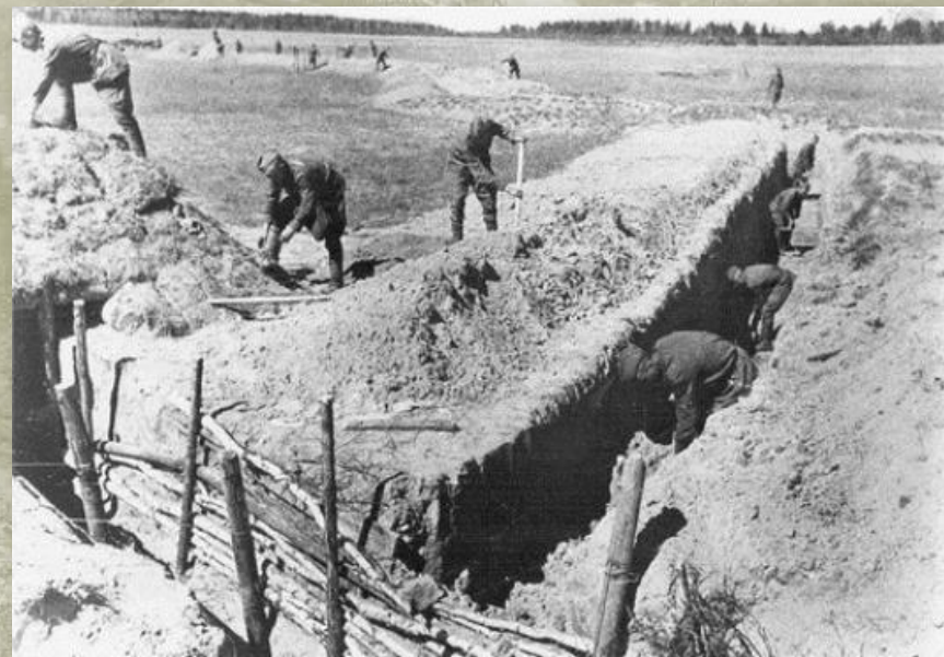
Строительство оборонительных сооружений на Курской Дуге. Июнь 1943.
